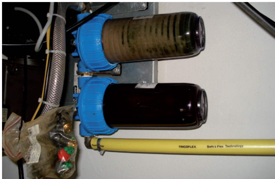
Abb. 6: Auch Filter sind bei der Reinigung und Desinfektion zu berücksichtigen. Deutlicher Biofilm im Filter (Anfang der Wasserleitung; Im Vorraum). Quelle: Dr. Pia Münster
