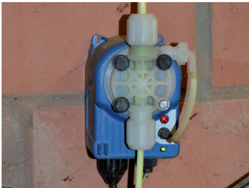
Abb. 7: Trinkwasserdesinfektion z.B. mit Chlordioxid ist eine geeignete Möglichkeit das Trinkwasser kontinuierlich zu desinfizieren. (Chlordioxidpumpe am Anfang des Leitungssystems) Quelle: Dr. Pia Münster
