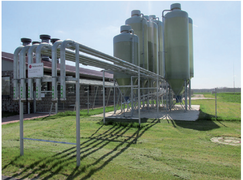
Ist ein neues Silo nötig, ist unbedingt an die Baugenehmigung zu denken! Quelle: Gerd Hermeling
